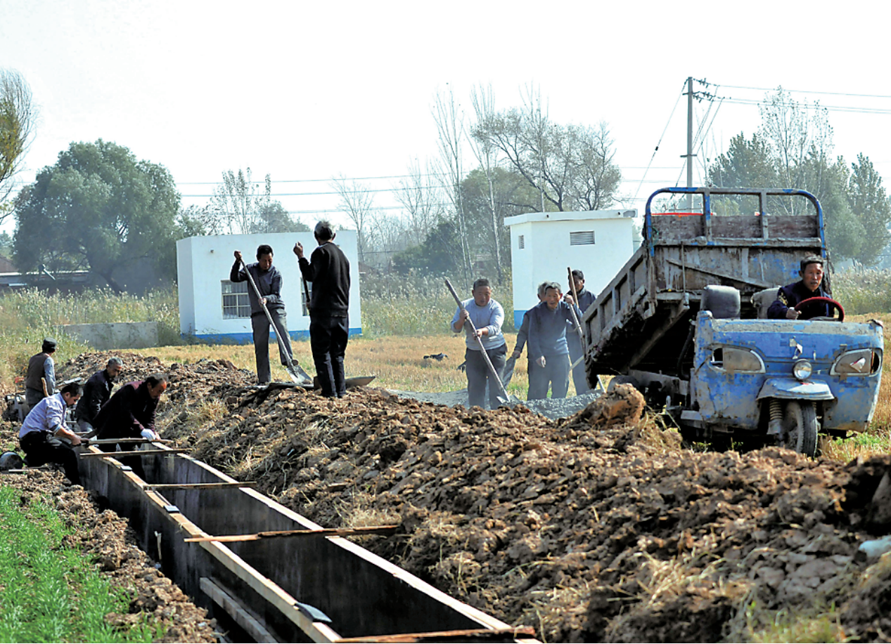
范县在今冬明春农田水利基本建设中,重点实施农村饮水安全巩固提升工程和农田水利基础设施万亩方、冬季沟渠清淤等一批重点水利工程。这些工程建成后,该县将新增有效灌溉面积0.6万亩、节水灌溉面积2万亩,同时将有效解决该县1.45万人的安全饮水问题。图为11月5日,在范县王楼镇大赵村农田里,工人们在进行矩形水渠混凝土浇筑。
