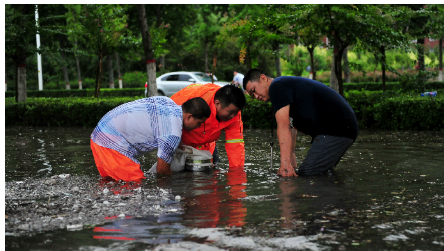
市政工人加班加点冒雨排放污水。
