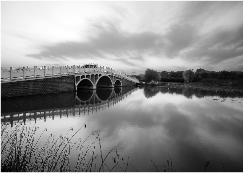
濮上生态园区水系一角。本报记者 贺德敬 摄
