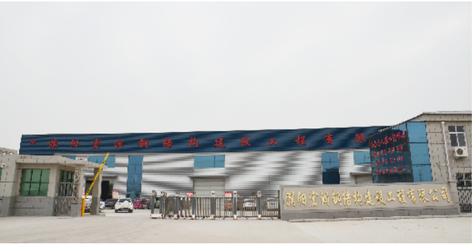
濮阳宏润钢结构建设工程有限公司。
