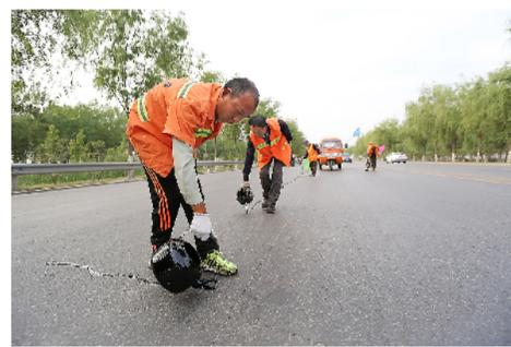
我市普通干线公路养护会战转入路面病害处治阶段以来,全市公路部门共挖补公路坑槽8670平方米、刷铺57480平方米、灌缝133859延米。图为5月13日,南乐县公路局员工对G106路面进行灌缝处理。
