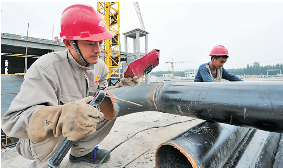
7月15日，位于市城乡一体化示范区的市第二污水处理厂二期工程项目工地，施工人员正在紧张施工。该项目占地面积约100亩，被列为省、市两级重点工程。截至目前，土建工程已完成总工程量的97%以上。
