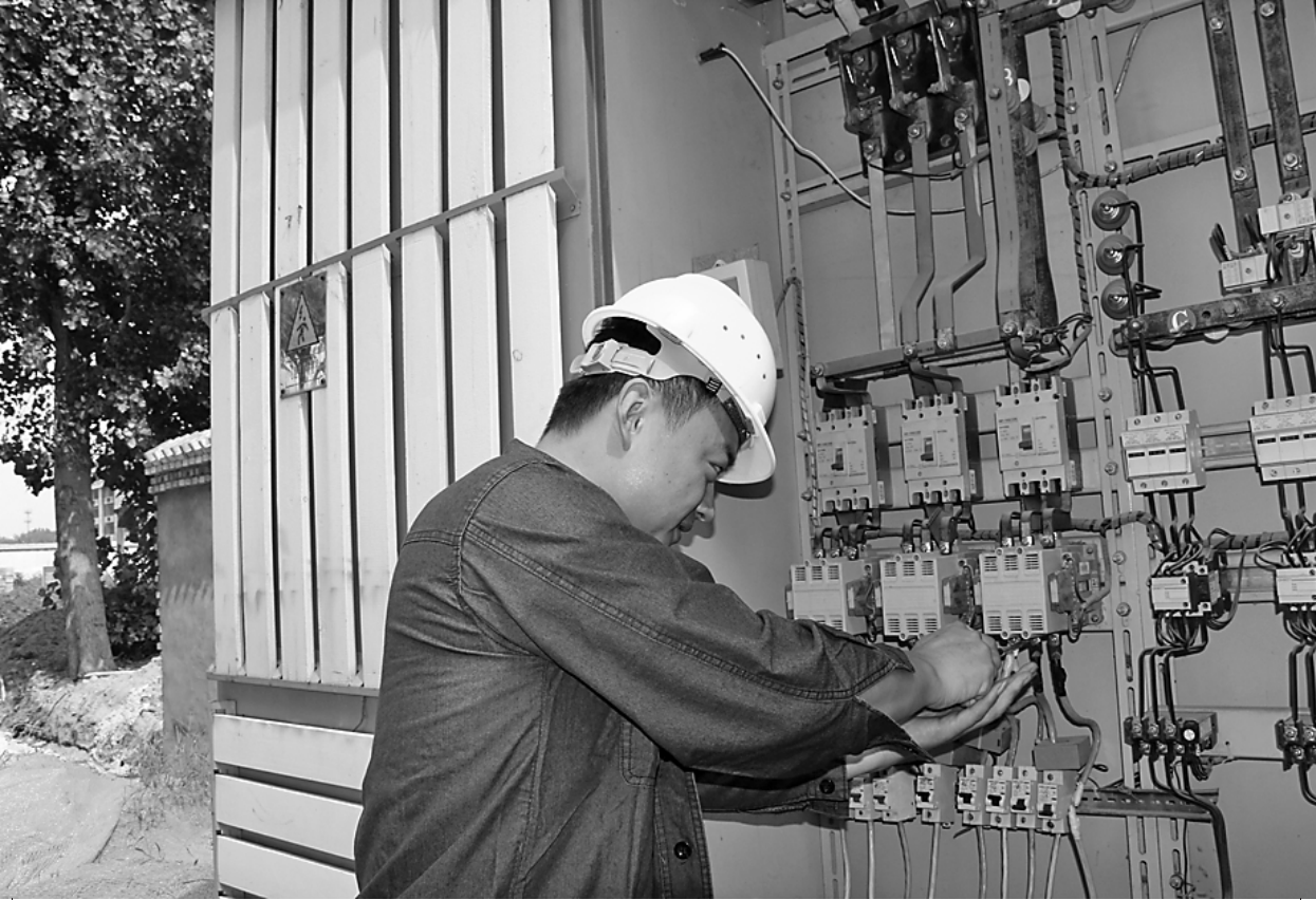
为确保市城区照明亮化设施在汛期安全、稳定运行,市城市照明管理处组织全体维修人员对辖区路灯、电缆线路等进行全面排查和集中维护,努力为广大市民打造一个安全、稳定的照明环境。图为8月8日,该处工作人员在市城区苏北路检修控制设备。
