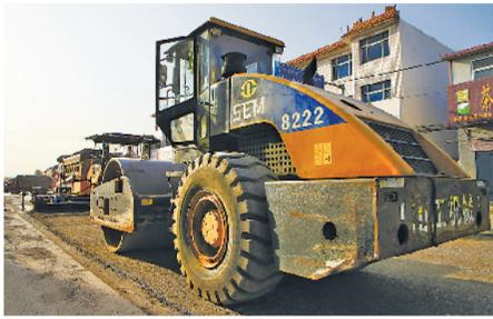
压路机对摊铺好水泥稳定碎石的路面进行压实。
