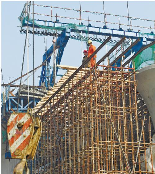
位于开发区新集镇仓上村的郑济铁路II标段跨省道特大桥40+56+40连续梁施工现场,工人在悬吊连续梁。
