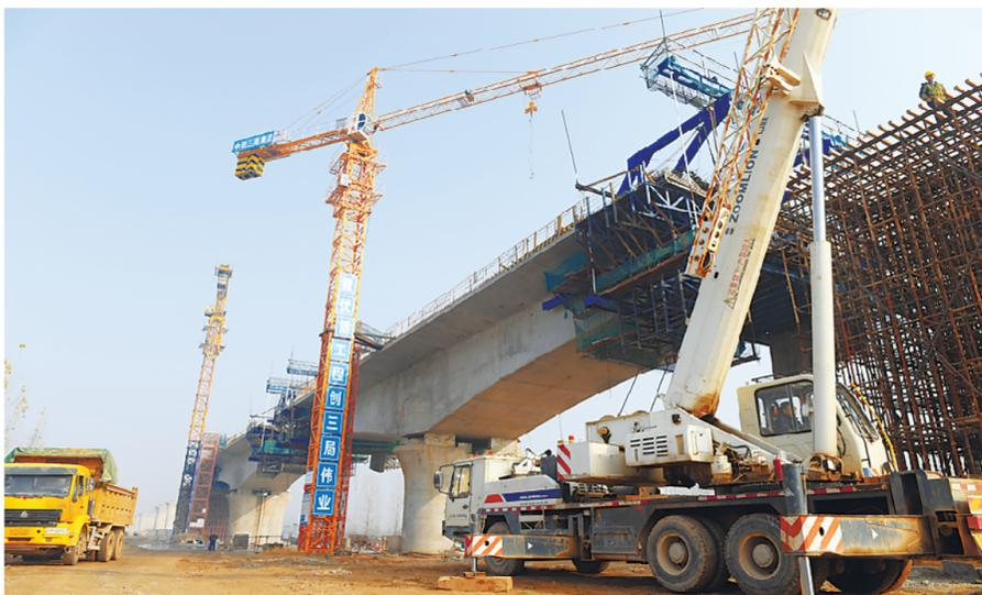
位于濮阳县清河头乡沙河寨村的郑济铁路I标段濮阳特大桥40+64+40连续梁施工现场。
