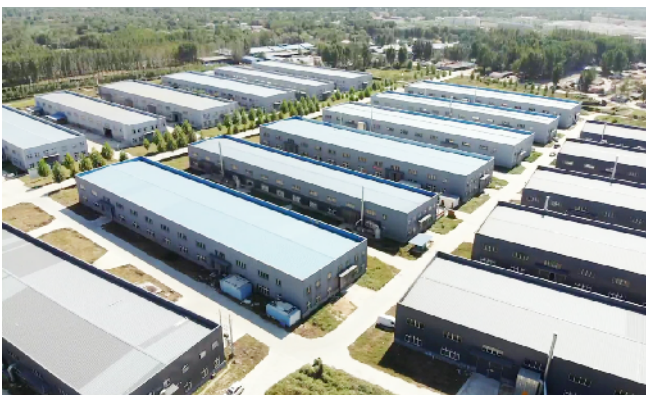
濮阳市木业产业园厂房林立。
