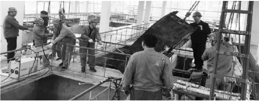
供水干部职工正在维修虹吸池组。
