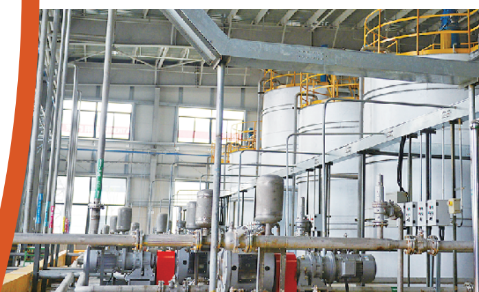
供热管网工程项目。
