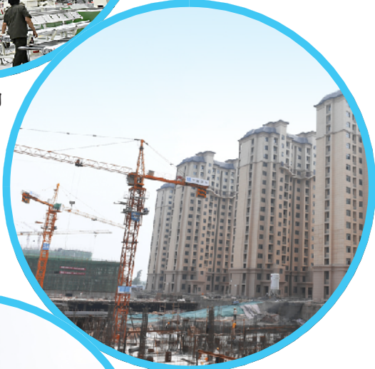
清丰县李家庄村棚户区改造项目工地。
