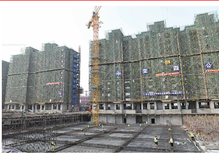
御井片区安置区建设工地。
