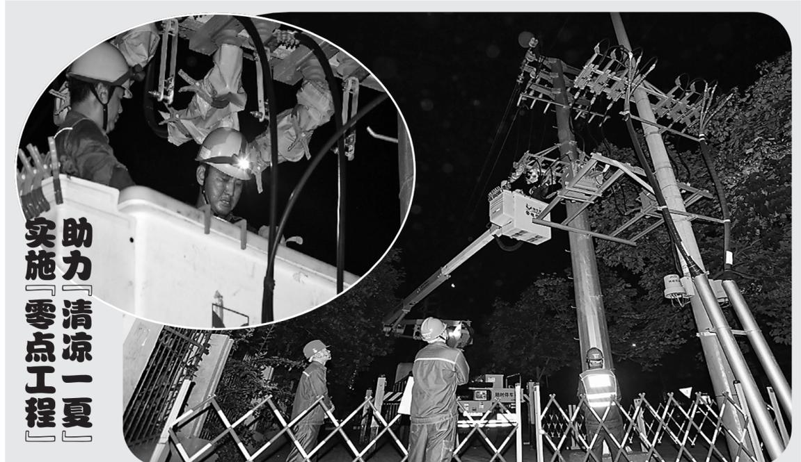
随着伏天的到来,我市供电负荷屡创新高,7月24日电网最大用电负荷达236.3万千瓦。连续高负荷运行,致使部分线路出现刀闸过热等问题。为维护线路运行安全,避免大面积停电等事故发生,近日,国网濮阳供电公司积极实施“零点工程”,在提升供电可靠性的同时,最大限度减少停电对群众生活的影响。迎峰度夏以来,该公司已开展“零点工程”及“带电作业”180余次。图为当日1时许,该公司工作人员在对10千伏1中原线金州段#2开关刀闸进行消缺作业。
