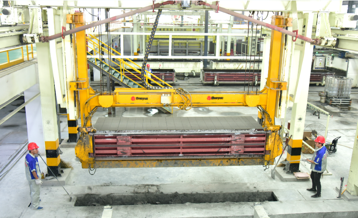
濮阳县通过强力治污，淘汰落后产能，发展新型产业，不断推动工业经济结构转型升级，实现绿色高质量发展。图为 8 月 22 日，濮阳县柳屯镇一家新型建材公司正在用粉煤灰、炉渣等固体废料生产新型建材。
