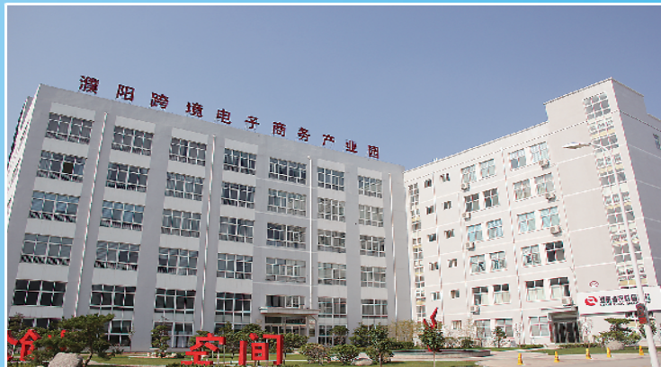
河南濮阳跨境电子商务产业园电商办公大楼。
