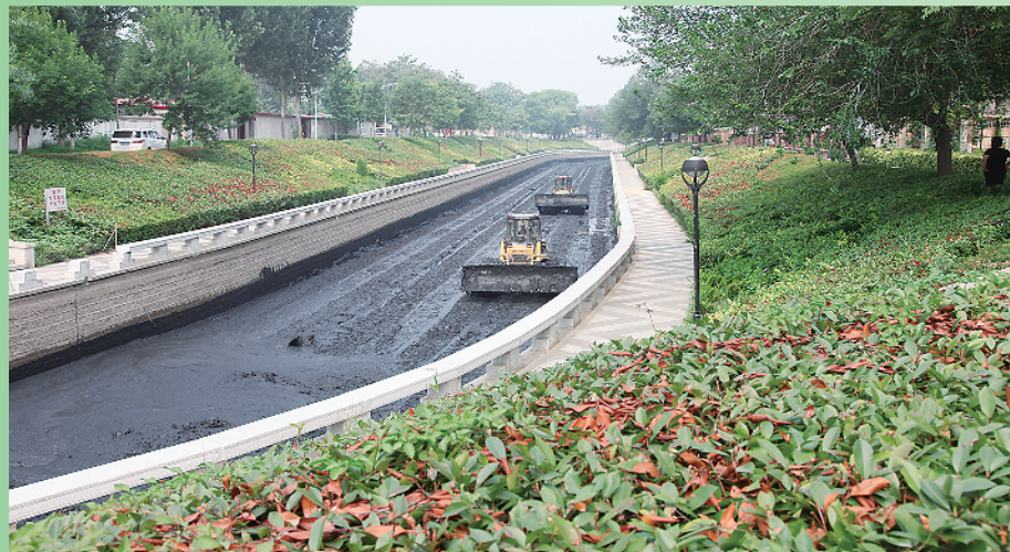
濮水河清淤施工。
