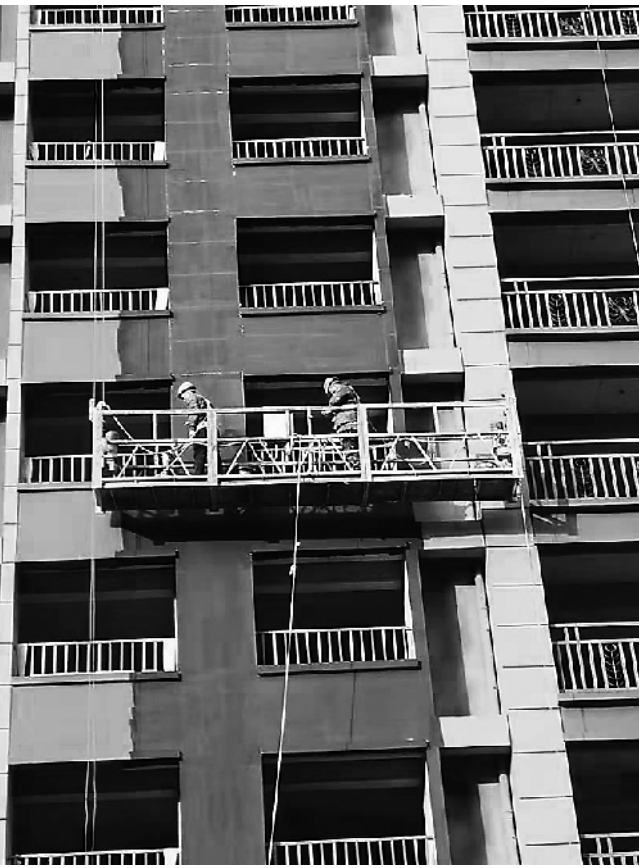
玖昌·悦府项目施工工地,有工人正在进行有机涂料喷涂作业。
