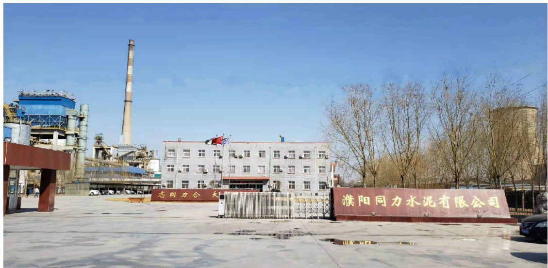
濮阳同力水泥有限公司厂区一隅。
