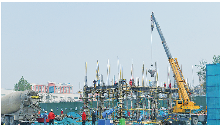
正在建设中的惠成化工二期。
