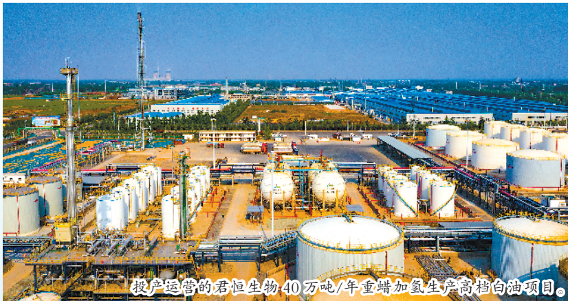
投产运营的君恒生物40万吨/年重蜡加氢生产高档白油项目。
