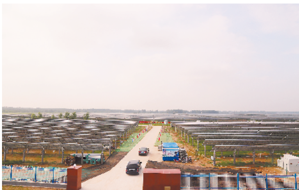
华电台前100兆瓦农光互补光伏扶贫项目建成并网发电。
