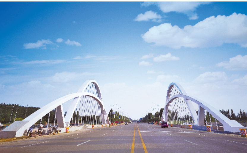
范县生态综合提升项目节点工程——范水飞虹。陆风国摄
