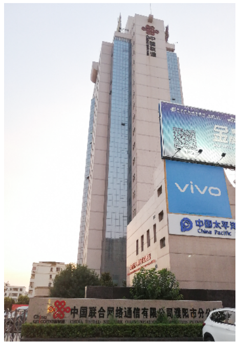
濮阳联通办公大楼。
