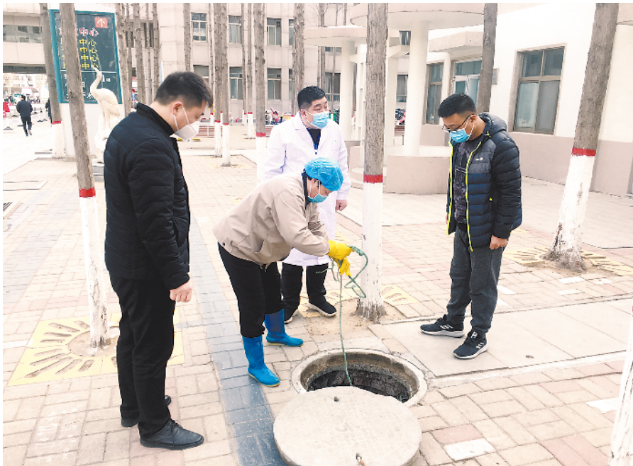
检查医疗废水处置情况。
