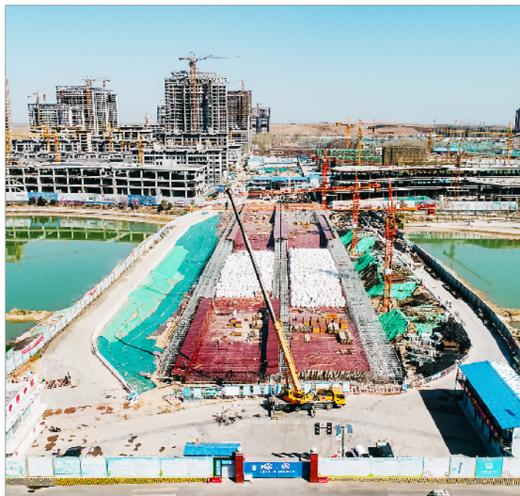
卫河路桥位于示范区东、西龙湖连接渠之上,规划宽度35.6米,桥梁全长200米,两侧跨径40米,中间跨径60米,总投资约8900万元,预计今年9月底全部完工通车。
