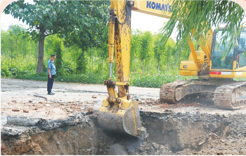
县交通运输局执法大队出动挖掘机对回填的公路路肩边沟恢复原状。 李晓松 摄
