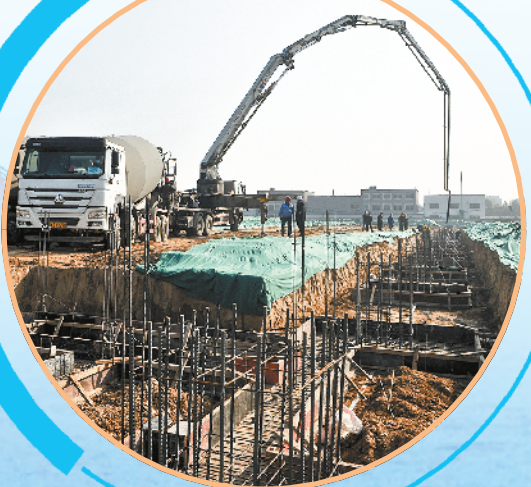
建设中的臣涛机械公司高端机械装备零部件项目。
