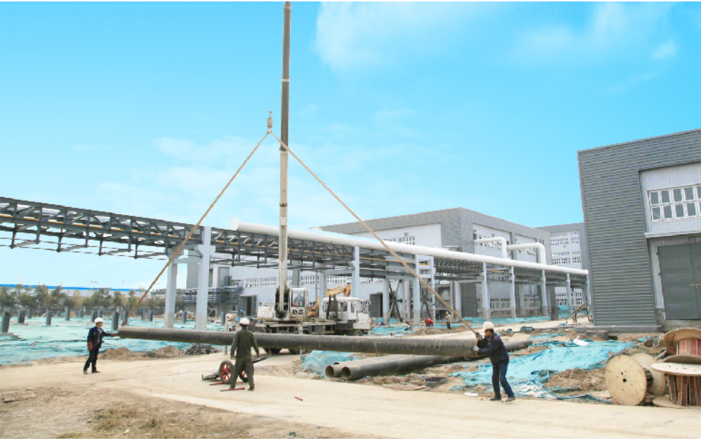
展展新材料项目建设现场。记者 张西恒 摄
