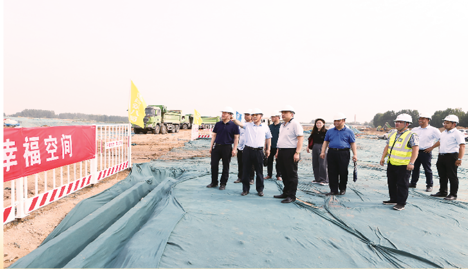
市审计局抓好政府投资项目跟踪审计工作, 局党组成员、副局长王万东深入施工现场调查取证。
