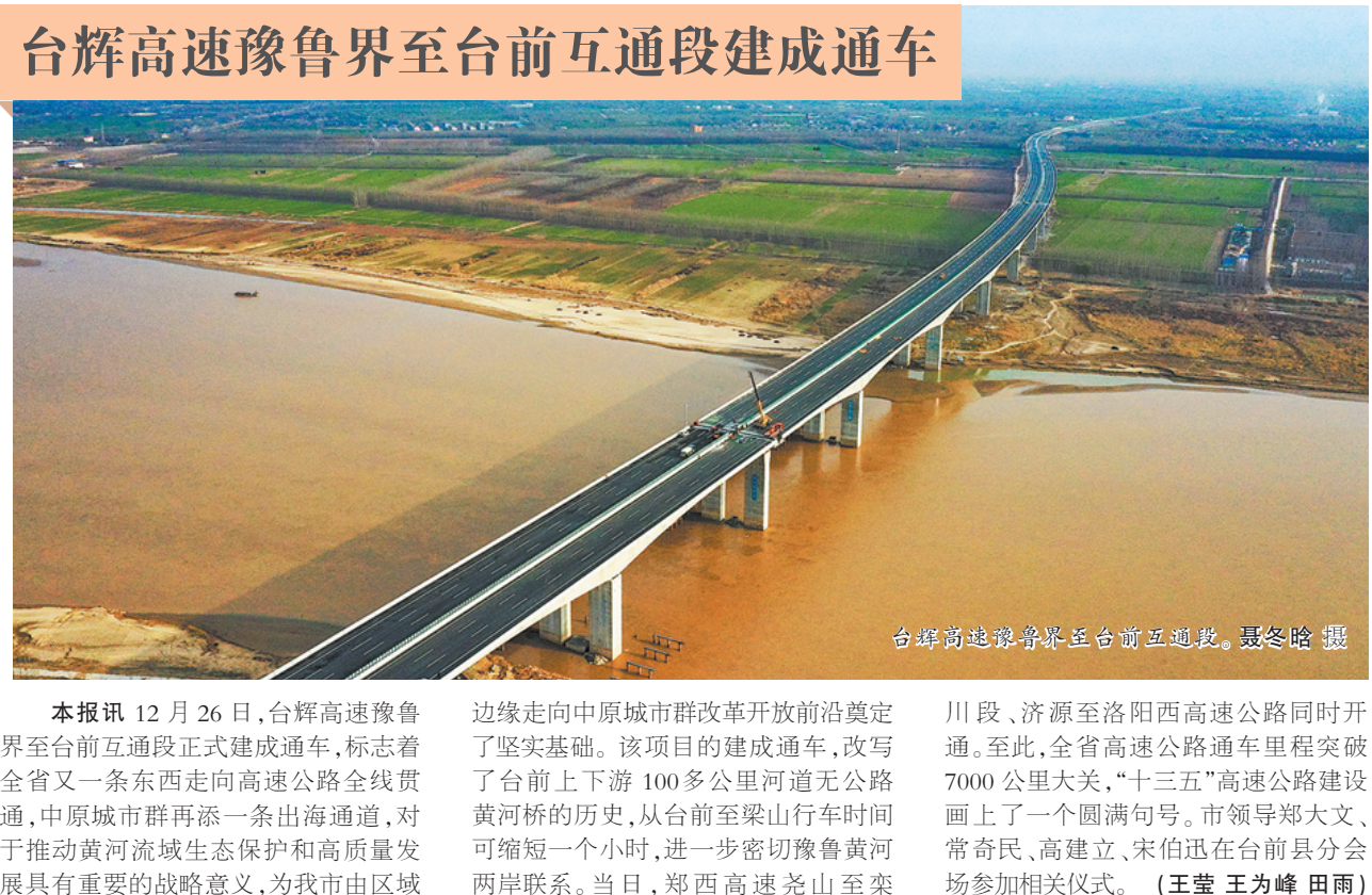
台辉高速豫鲁界至台前互通段建成通车 台辉高速豫鲁界至台前互通段。摄 王冬 摄 本报讯 12 月 26 日，台辉高速豫鲁界至台前互通段正式建成通车，标志着全省又一条东西走向高速公路全线贯通，中原城市群再添一条出海通道，对于推动黄河流域生态保护和高质量发展具有重要的战略意义，为我市由区域边缘走向中原城市群改革开放前沿奠定了坚实基础。该项目的建成通车，改写了台前上下游 100 多公里河道无公路黄河桥的历史，从台前至梁山行车时间可缩短一个小时，进一步密切豫鲁黄河两岸联系。当日，郑西高速尧山至栾川段、济源至洛阳西高速公路同时开通。至此，全省高速公路通车里程突破 7000 公里大关，“十三五”高速公路建设画上了一个圆满句号。市领导郑大文、常奇民、高建立、宋伯迅在台前县分会场参加相关仪式。（王莹 王为峰 田雨）
