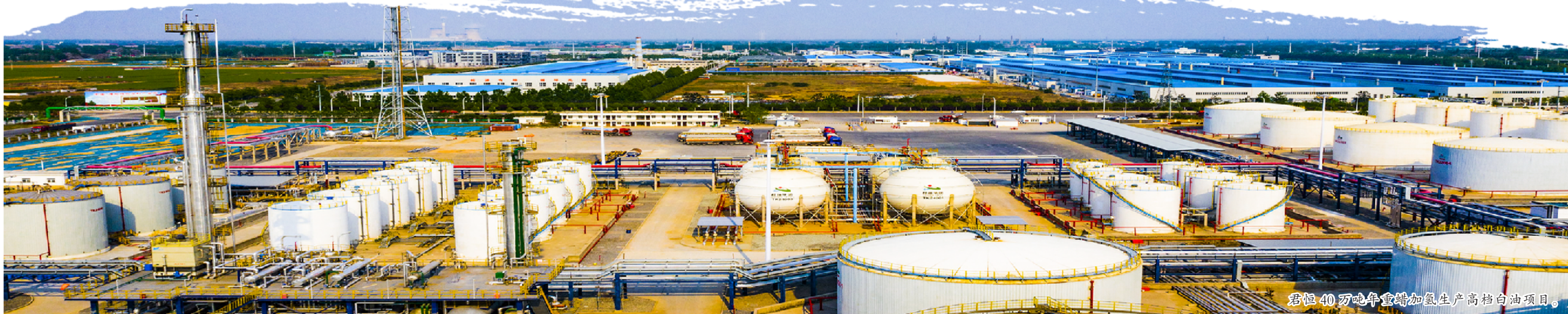
君恒40万吨年重蜡加氢生产高档白油项目。
