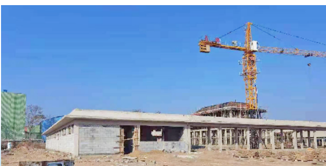
濮阳县公益性公墓和骨灰堂正在建设中。
