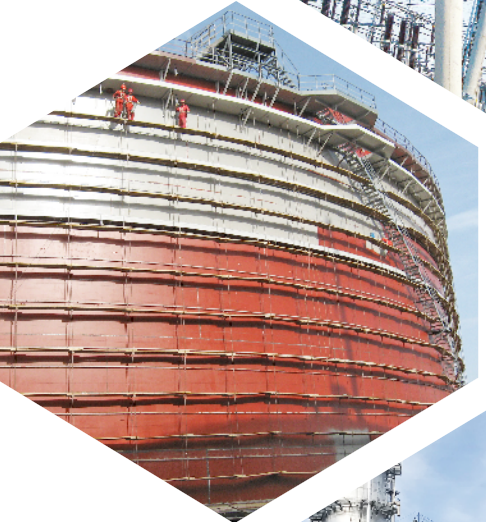
石油储罐外防腐。
