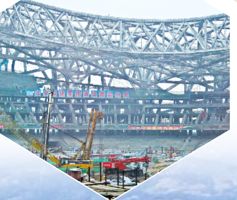
国家鸟巢钢结构防腐工程。
