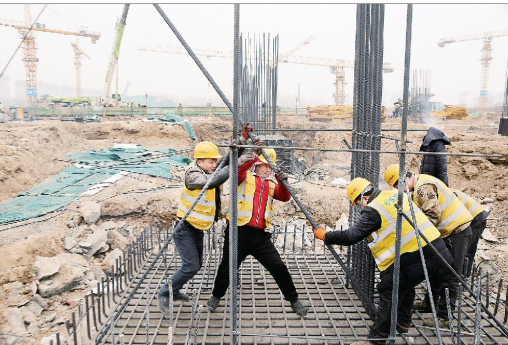
郑济高铁濮阳东站施工建设正紧锣密鼓地按照时间节点顺利进行。目前,濮阳东站已完成站房桩基础工程,正在进行承台地梁施工,预计今年4月初完成站房主体结构,6月底完成钢结构,12月具备竣工验收条件。因为1月28日,施工工人正在进行承台地梁施工。
