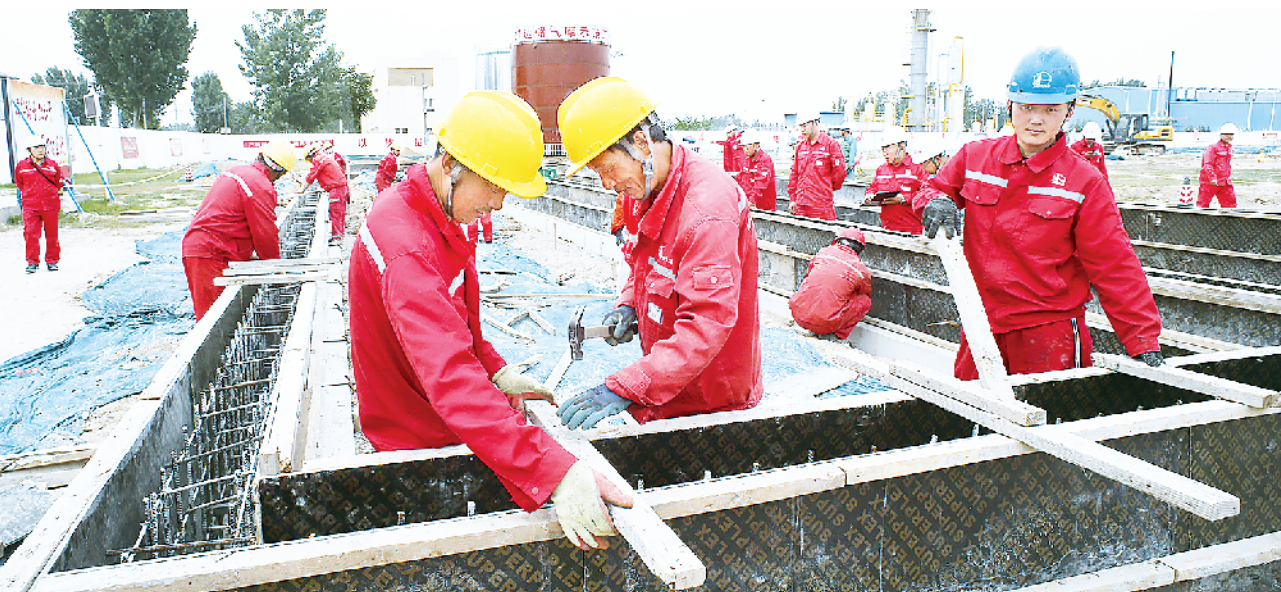
位于濮阳县文留镇境内的文13西储气库地面工程自3月底开工建设以来,负责工程设计的中原石油工程设计有限公司和担负施工任务的中原建设工程有限公司密切配合,近百名职工奋战在施工现场,目前储气库地面基础工程已完成总进度的90%,进展顺利。图为7月6日,工人正在文13西储气库进行基础工程施工。本报记者 贺德敬 摄
