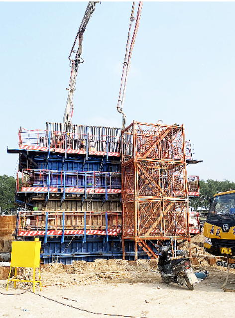
项目施工现场。
