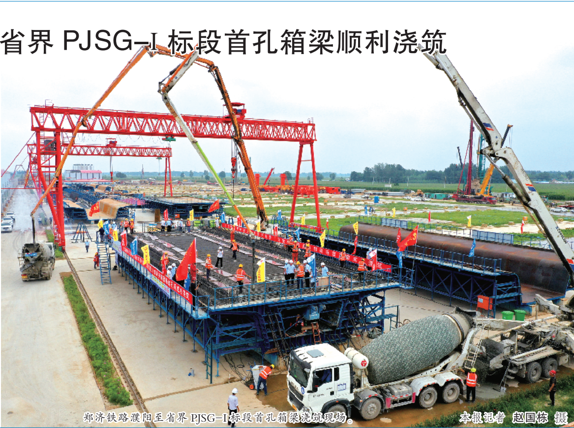
郑济铁路濮阳至省界PJSG-I标段首孔箱梁浇筑现场。
