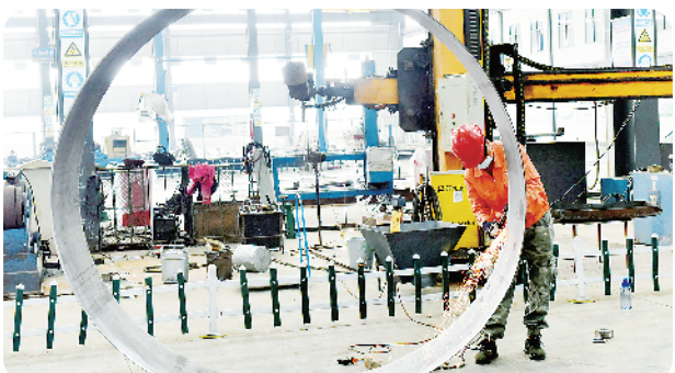
濮阳县积极协调项目用地,大力支持海林特种设备制造防护有限公司,新增移动压力罐车、专用车辆改装等项目。图为近日该企业员工正在焊接压力罐部件。
