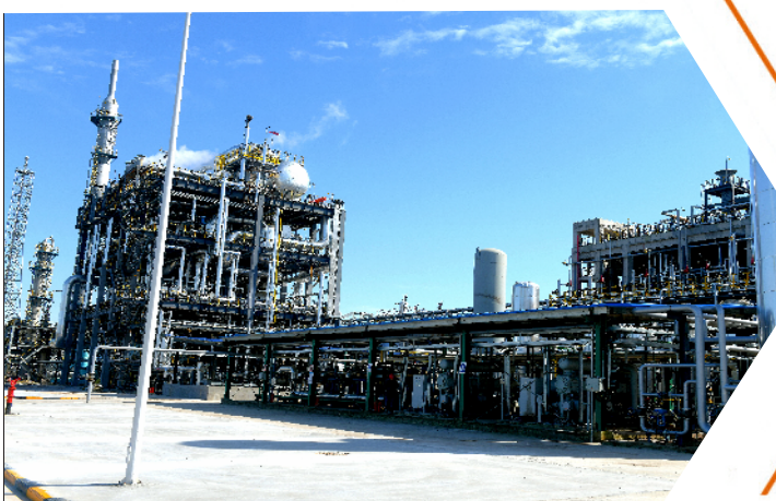
朗润新材料循环经济产业园项目。
