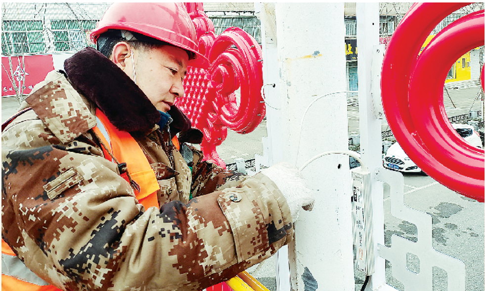
1 月 12 日，市城市照明管理处工作人员在胜利路安装节日彩灯。 本报记者 高崧人 通讯员 徐利明 摄
