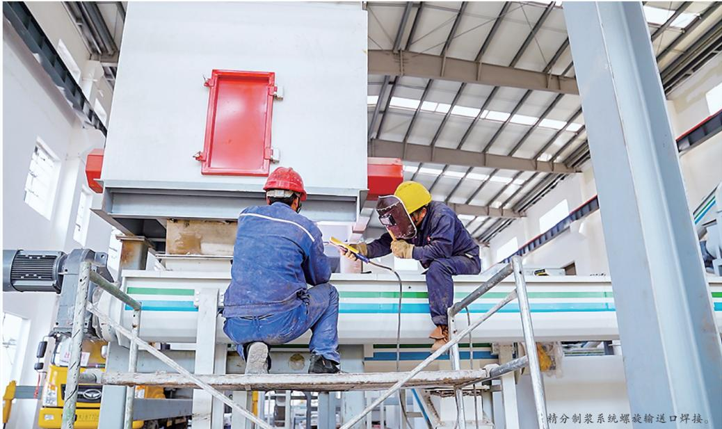
精制制浆系统螺旋输送机焊接。
