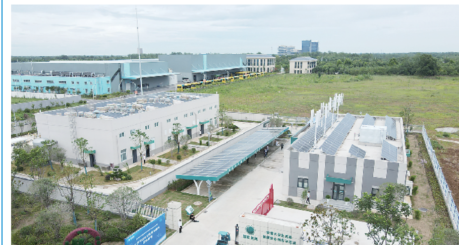
这是 7 月 6 日拍摄的安徽六安兆瓦级氢能综合利用示范站(无人机照片)。
