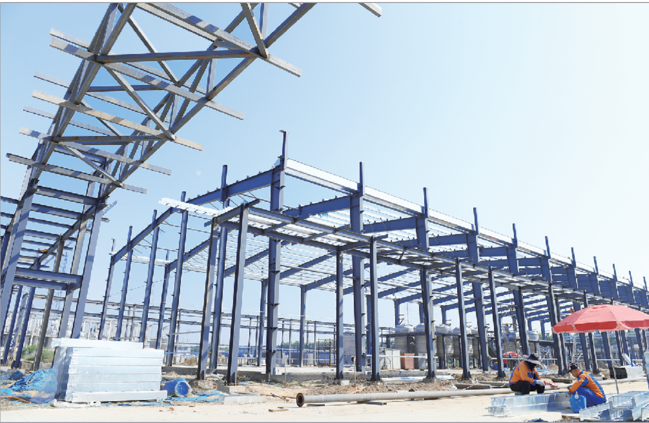
10月9日,位于开发区的乐享化科合成橡胶新材料项目建筑工地上,工人在忙碌着。该项目总投资11.7亿元,占地312.45亩,分两期建设。目前,一期项目已投产,二期项目正在建设中。项目全部建成达产后,将成为国内最大的复合橡胶新材料生产基地。 本报记者 僧少琴 摄
