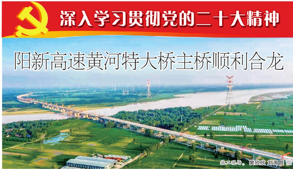
本报讯(记者樊欣欣通讯员刘海昌)11月6日深夜,阳新高速黄河特大桥施工现场灯火通明,在紧张有序的机器轰鸣声中,随着最后一盘混凝土徐徐浇筑入模板中,阳新高速黄河特大桥主桥顺利合龙,标志着全桥上部主体结构完工,为全桥贯通打下坚实基础。
