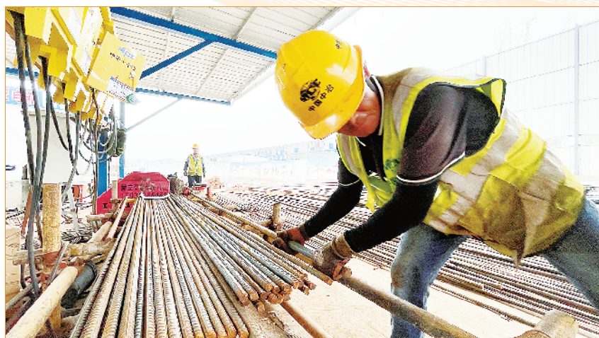
建筑工人正在加工钢筋。
