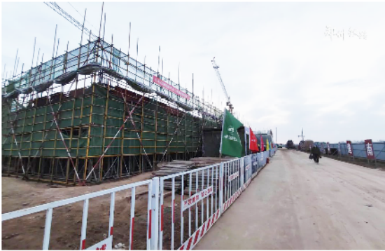
南乐站首层顶板及钢筋安装。
