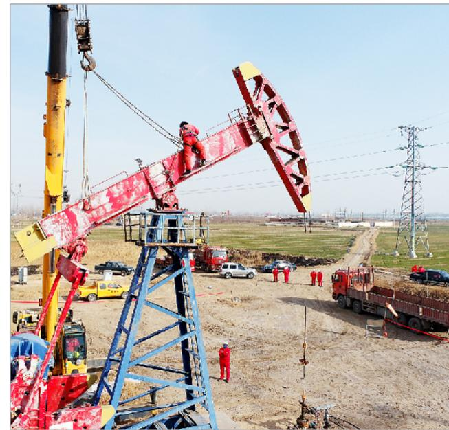
1月18日,中国石化中原油田地面工程抢险维修中心文留工区职工在文95-85井拆卸抽油机。新年伊始,中国石化中原油田地面工程抢险维修中心广大干部职工坚守岗位,做好油气安全生产服务工作,全力保障新年开好局、起好步。年初至今,共装机9台、拆机12台、拆转机17台,整改25台次。
