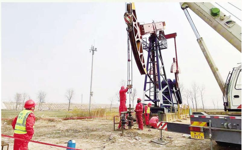
为保障采油一线春季安全生产,中原油田濮东采油厂对生产设备运行状况进行全面“体检”。图为2月20日,该厂技术人员在胡39-23井现场指导工人对抽油杆和井口设备进行安全检查和维护保养。
